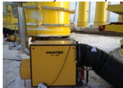
Строительные площадки со сложными условиями работы
