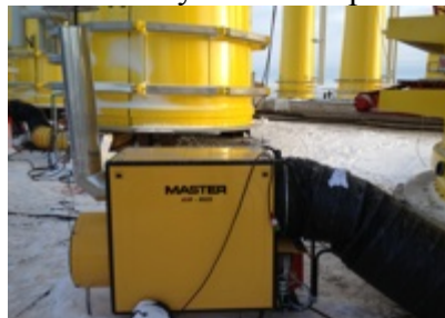
Строительные площадки со сложными условиями работы
